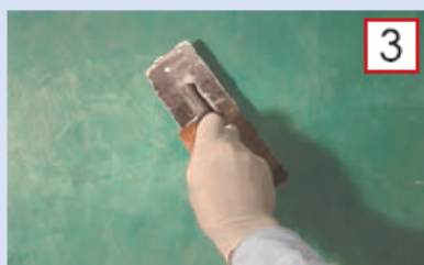
Нанесите декоративный слой Trevignano и уплотните его.
