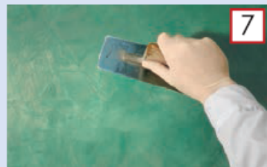
Проведите железнение поверхности.
