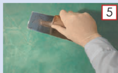
Проведите железнение поверхности.
