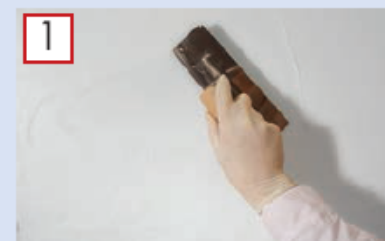
Нанесите Travertino/Travertino naturale кельмой.
