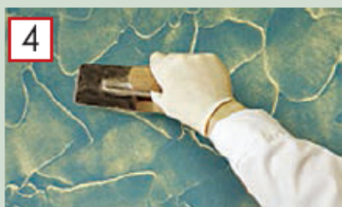
Нанесите с помощью кельмы
