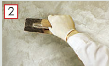
Нанесите с помощью кельмы.
