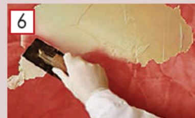
Нанесите отделочный слой.
