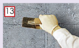
Зажелезните поверхность кельмой.
