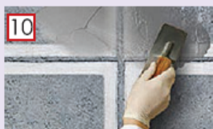
Имитируем выполование бетона.
