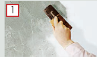
Нанесите Loft beton.
